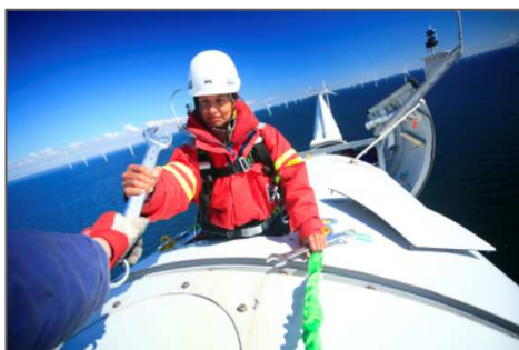
Service- und Reparaturarbeiten an einer Offshore- Windanlage
